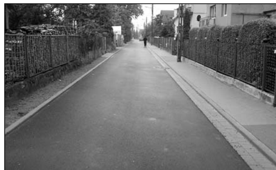
Ulica Różana w Dobroszycach po przebudowie.
